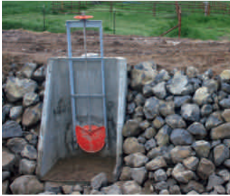
Se retira la compuerta manual existente...
